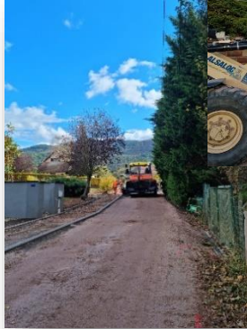
Travaux rue des Alouettes et rue de Dambach
